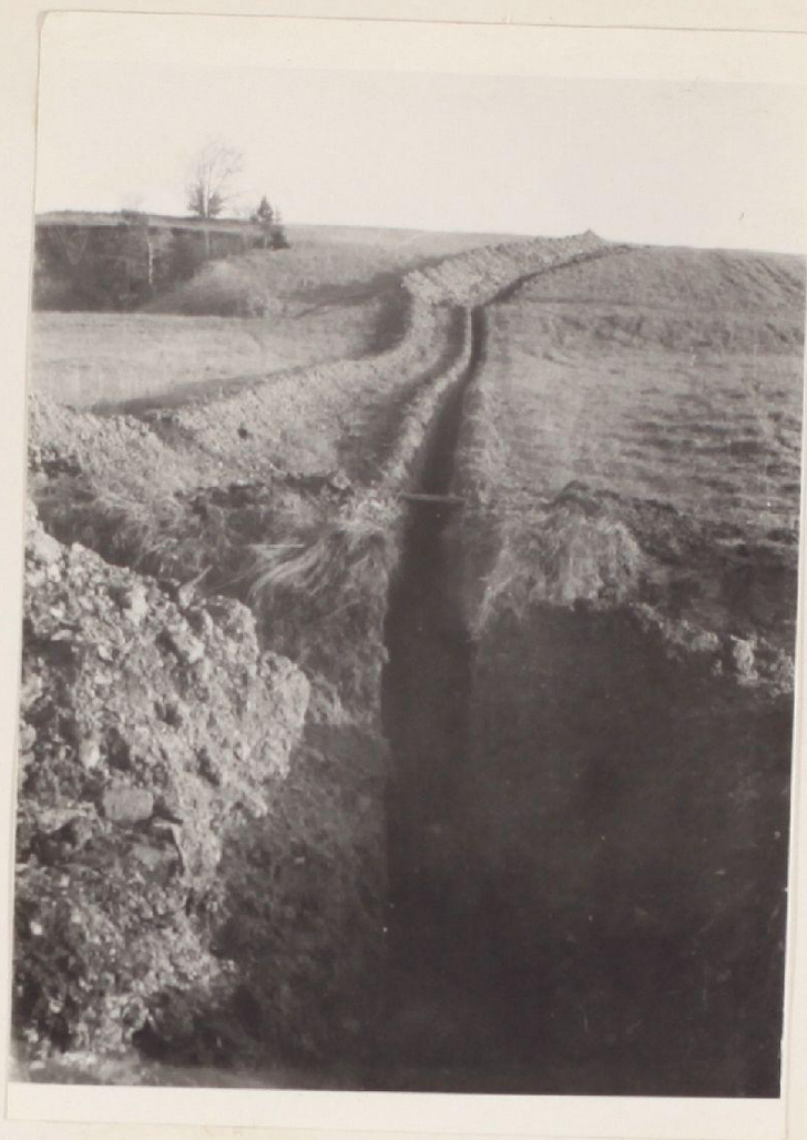
Výkop pro uložení kanalizačního potrubí k vodojemu.
