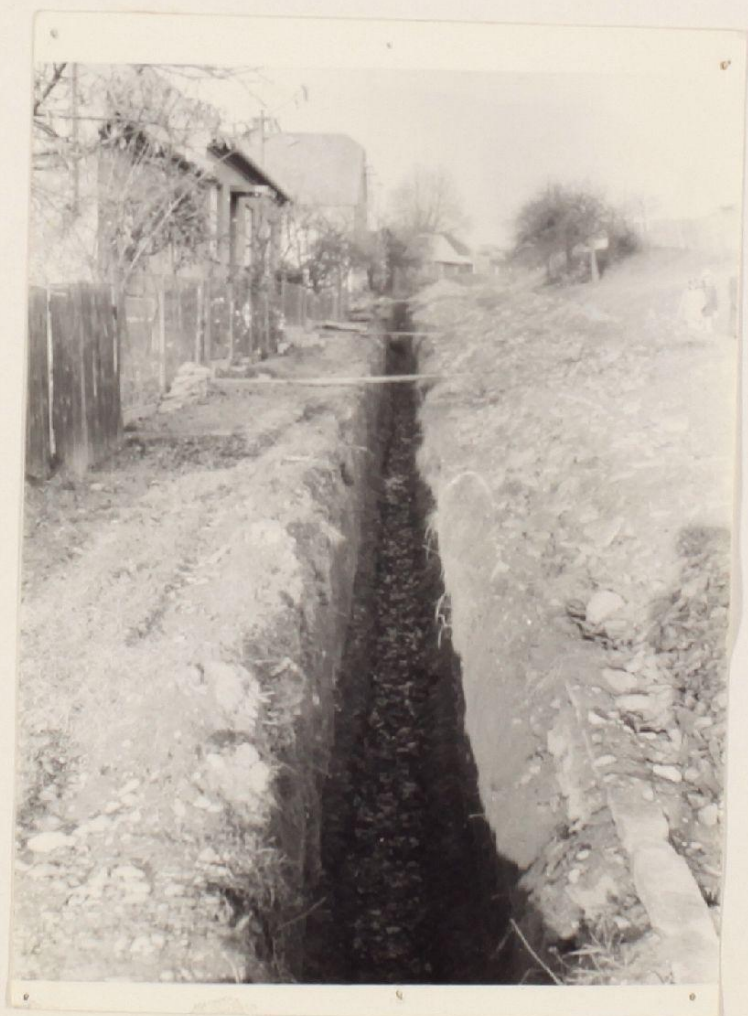
Výkop připravený k pokládání kanalizačního potrubí.
