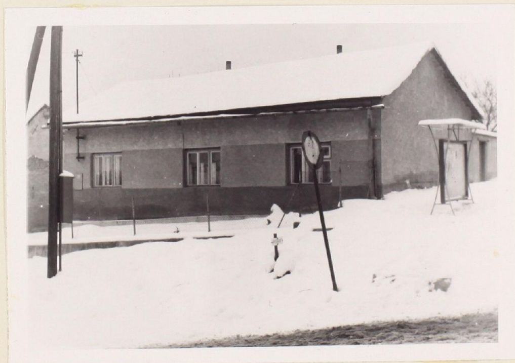
Dům č. 42 po opravě. Fotografovala v roce 1978 s. Vlasta Kopečná.
