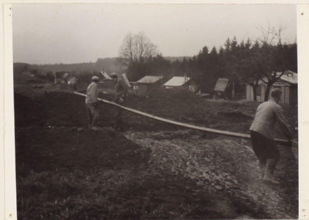
Přenašeni vodorodního potrubí.
