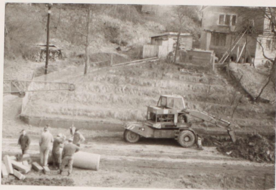
Budování kanalizace u Kozelkového.
