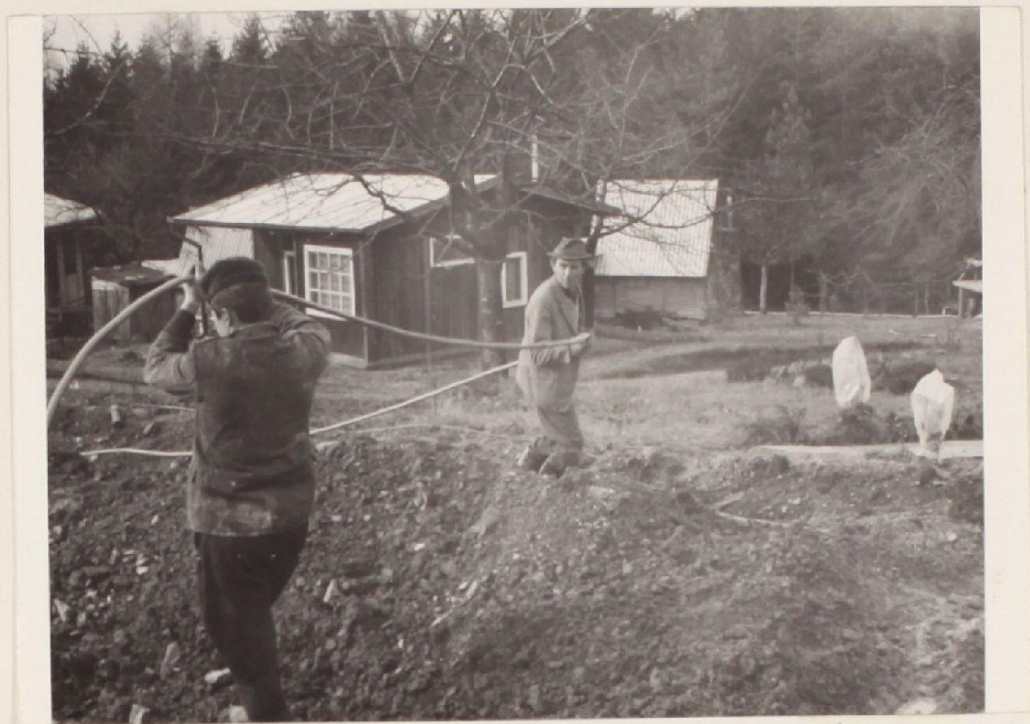
Natahování elektrického kabelu k vodojemu. Vpravo Karel Sklenář.
