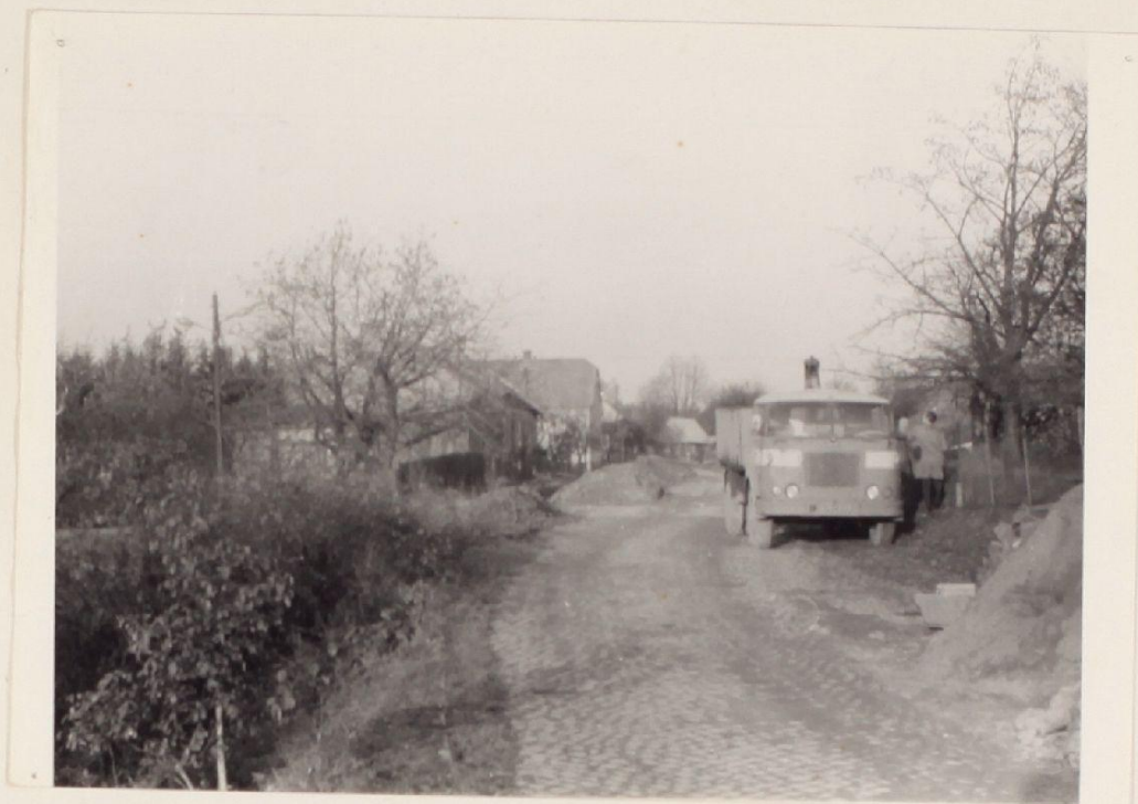
Výkop připravený k pokládání kanalizačního potrubí.
