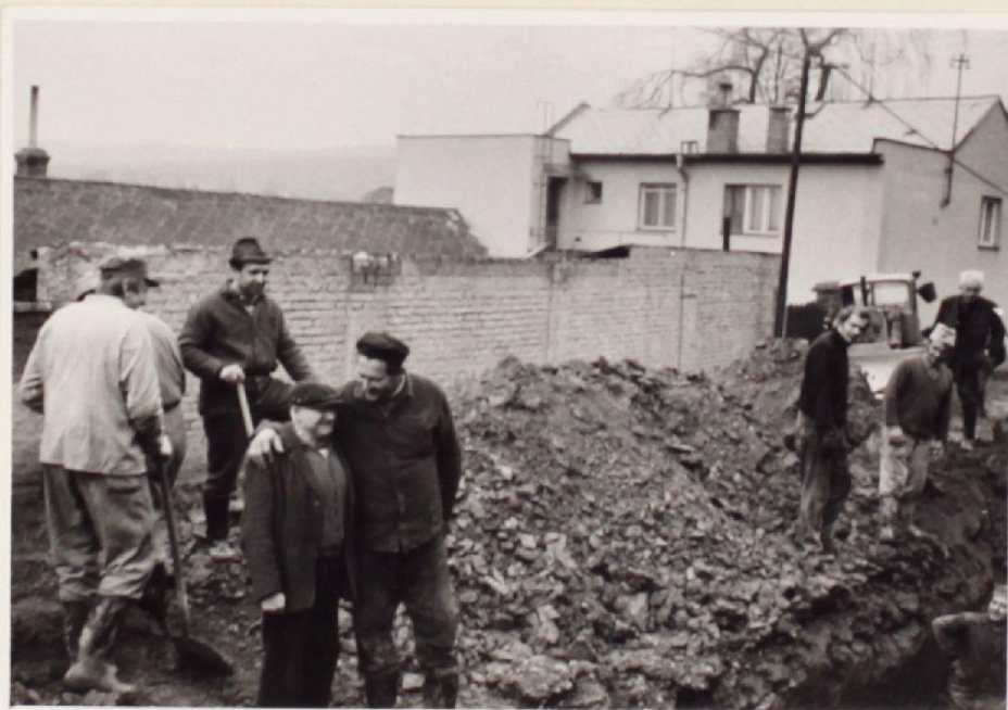
Budování kanalizace u kulturního domu.
