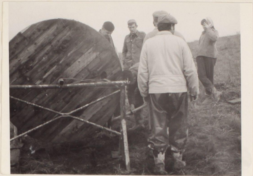
Pokládání kabelu elektrického vedení k vodojemu. Lošovským občanům pomáhají sovětské vojáci.
